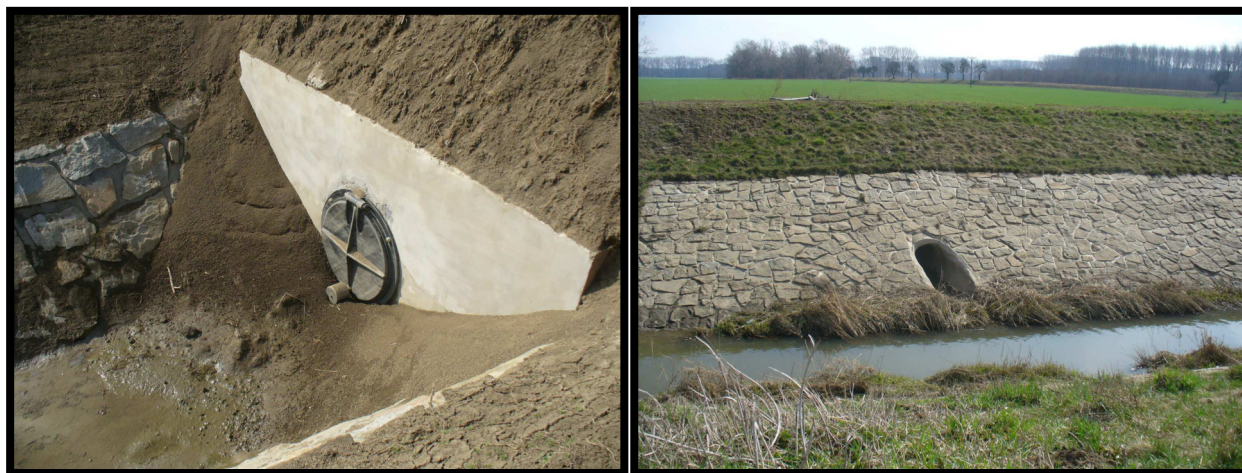
Obr: Zpětné klapky na objektech k převodu vody ze suchých poldrů do Syrovinky
